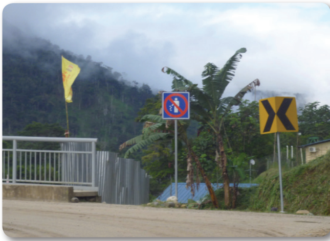
Puente sobre el Río Zamora construido por la ECSA. Ondea una bandera en chino. Fuente: diario de campo.
