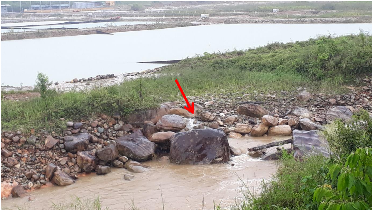
Figura 7: descarga descontrolada de agua de las piscinas de sedimentación al Río Tundayme y aguas turbias de un brazo del Río Tundayme. Fuente: Colectivo de Geografía Crítica del Ecuador 2019.
